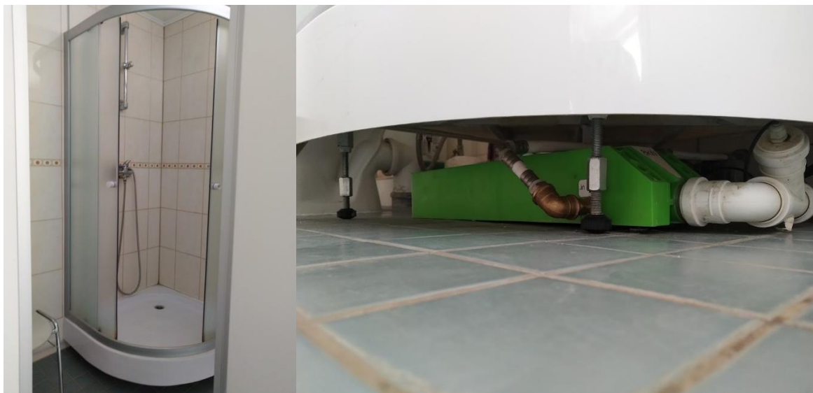
PILT 3.3 Dušinurk ja soojustagasti dušinurga all Paagi tn 8 objektil
